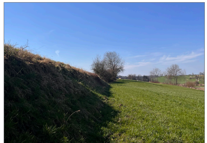
Abb. 3: Mittlerer Abschnitt der Hecke extensiv genutzter Böschungsabschnitt - wenig arteneich/graslastig. Foto: Götsch 2026.
