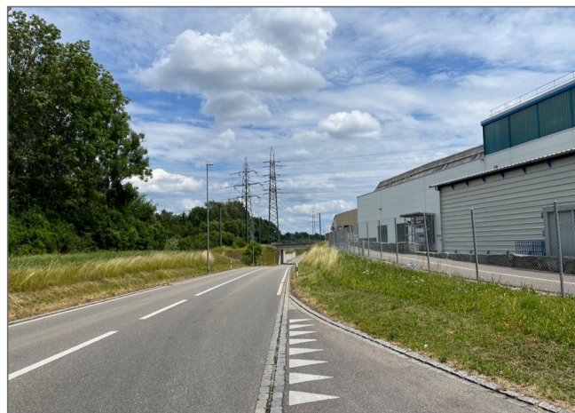
Abb. 2: Die östliche Allee ist nicht vorhanden. Foto: Götsch 2023.
