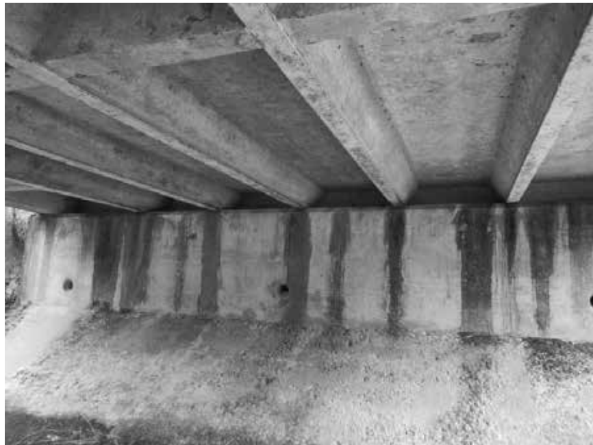
Untersicht der Brücke
