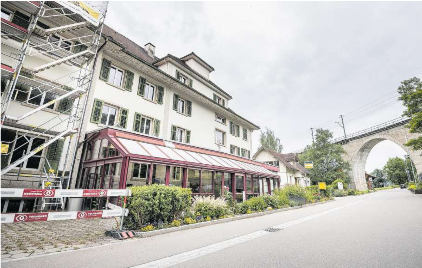
Bereits vor einem Jahr sah man die Bauarbeiten am Altbau des Alterszentrums.
