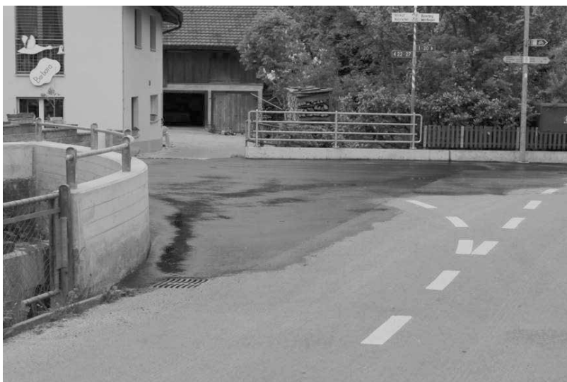
Die neugestaltete Fahrbahn mit den Abschränkungen
