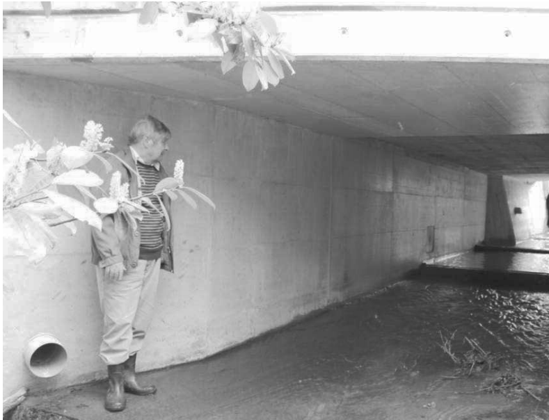
Der sanierte Bachdurchlass mit dem Bauleiter Herr Acanski
