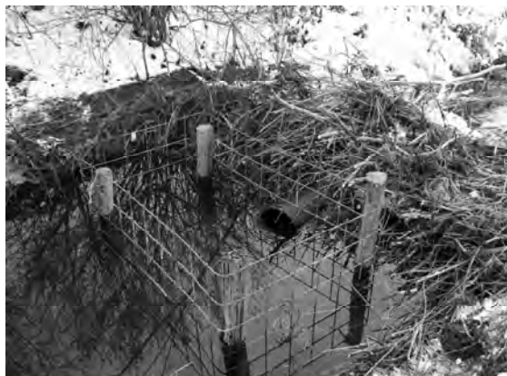
Damm mit Röhre und Gitter (Bild: A.Gurtner)
