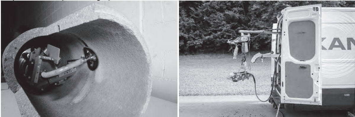
Abbildung 3: Robotersanierung; links: Roboter beim verputzen eines Risses; rechts: Fahrzeug für Robotersanierung
